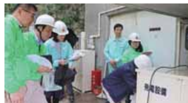
情報発信訓練で防災用LPガス発電機の操作を行う教職員
